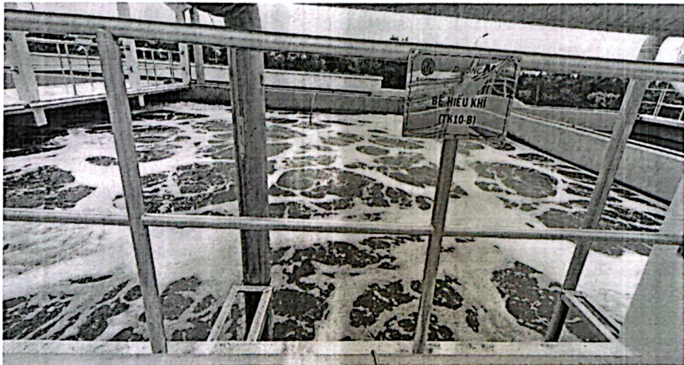
Hình Error! No text of specified style in document..7: Bể hiếu khí
