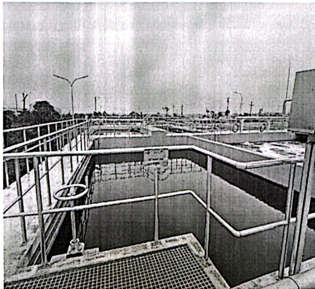
Hình Error! No text of specified style in document..4: Bể điều hòa, Bể trung gian
