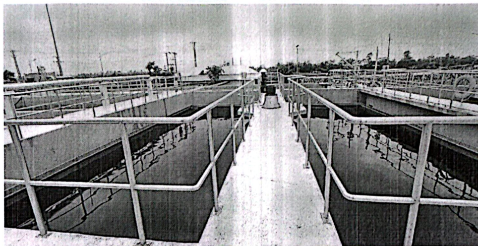
Hình Error! No text of specified style in document..8: Bể lắng thứ cấp
